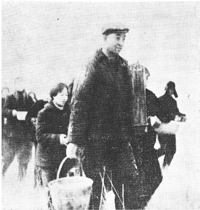
Post la instalo de la unua drilmaŝino ili alportis akvon per diversaj ujoj por tuj funkciigi la maŝinon.
