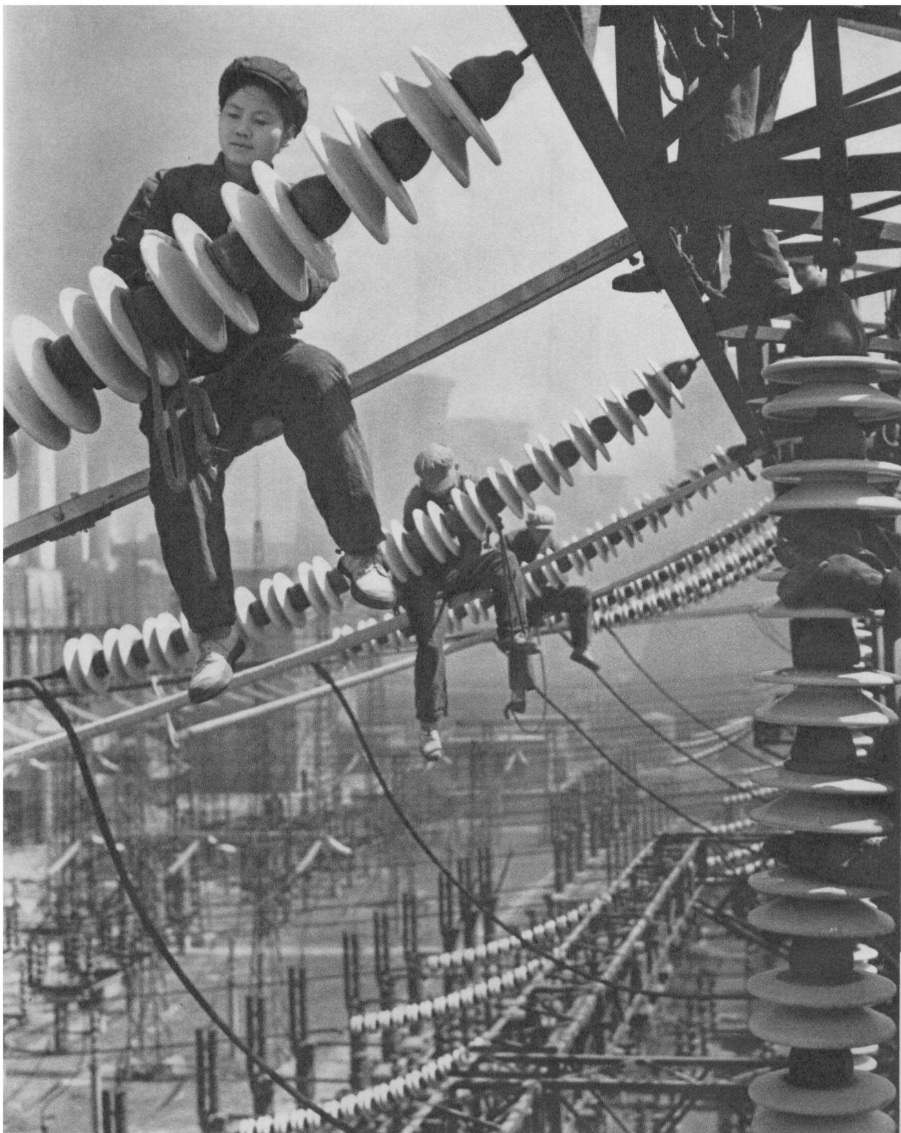
Laboristoj de la Fuhin-a Elektrejo de Liaŭning-provinco laboras sur alttensia linio sen interrompo de kurento.
