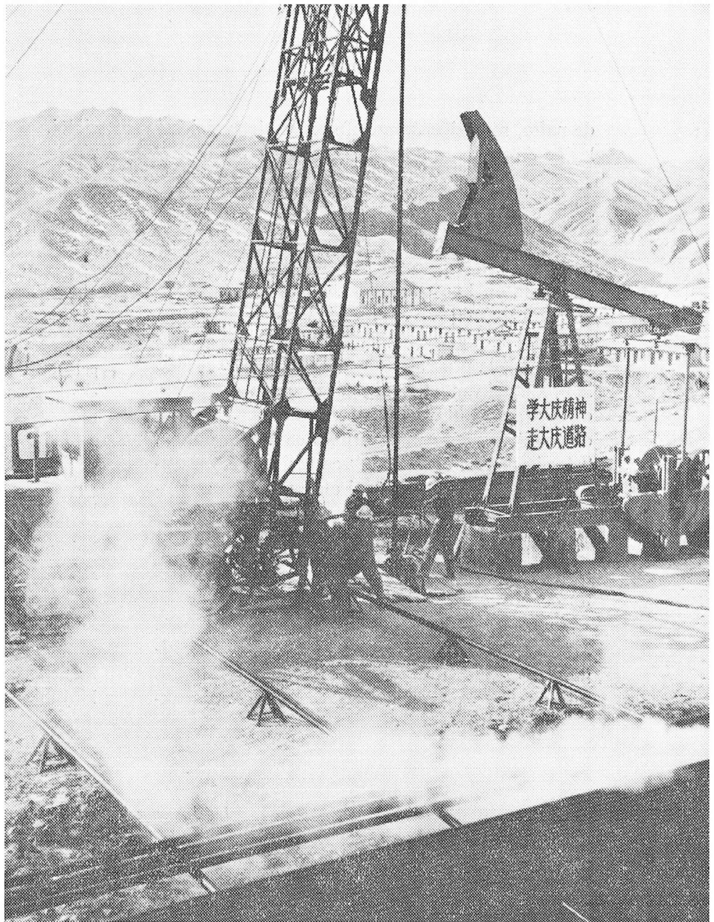
Laboristoj riparas forlasitan oleputon.
