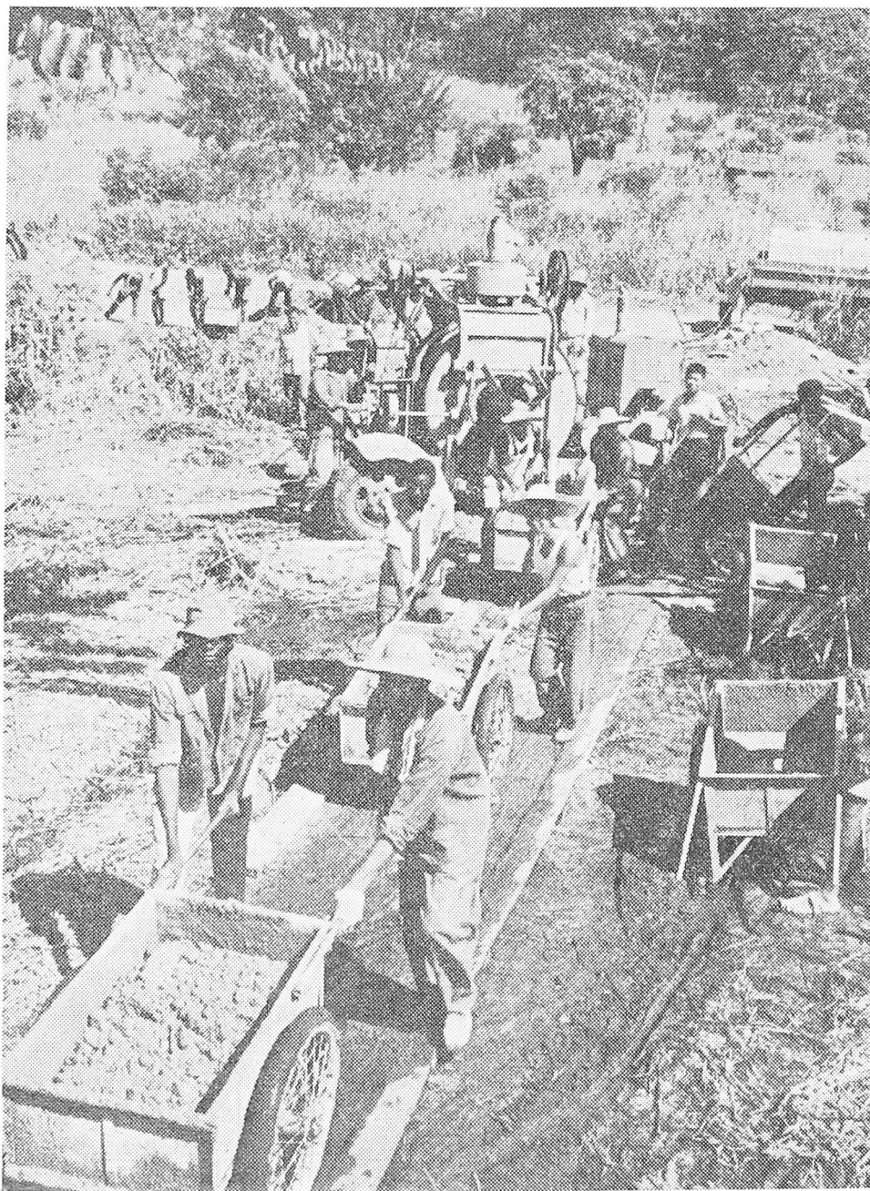
Ĉinaj konstruaj teknikistoj kaj tanzaniaj laboristoj faras preparajn laborojn por la konstruado.
