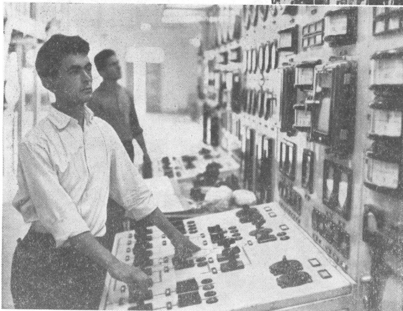
Laboristoj de la Termoelektra Centralo de Fier estas en laboro.
