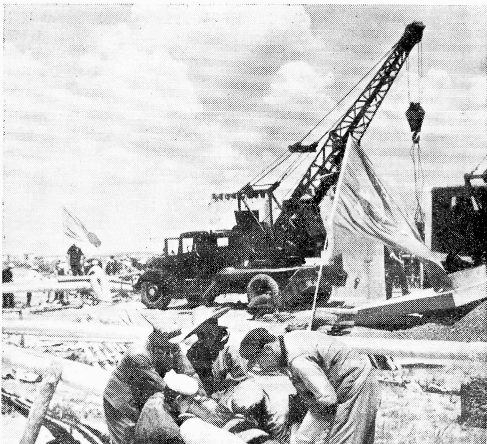
La daking-aj laboristoj instalas konduktubon por rapidigi la konstruadon de la olekampo.
