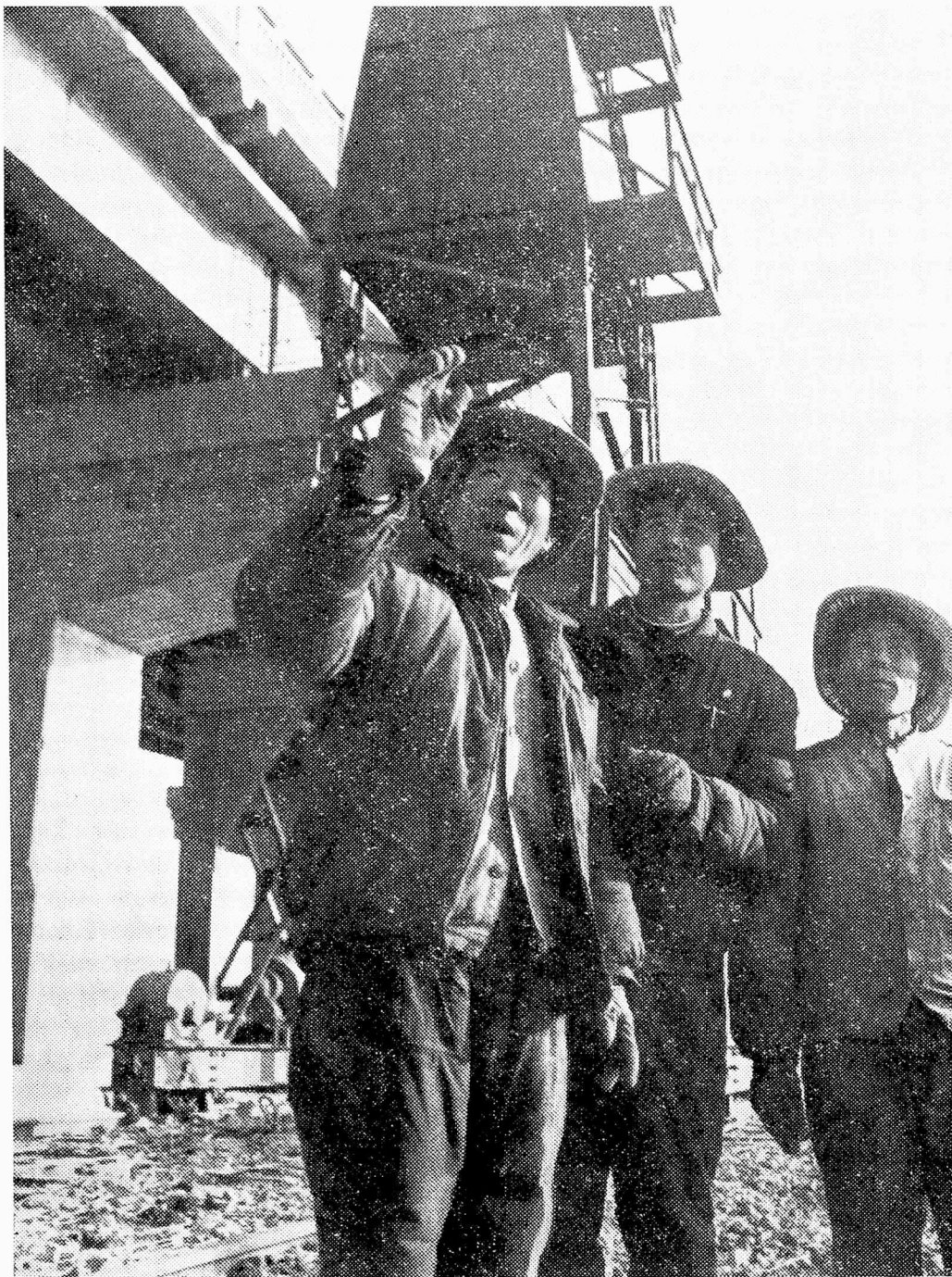
Kamarado Vang Ĉaŭĝu kaj laboristoj sur la konstruejo de la ponto
