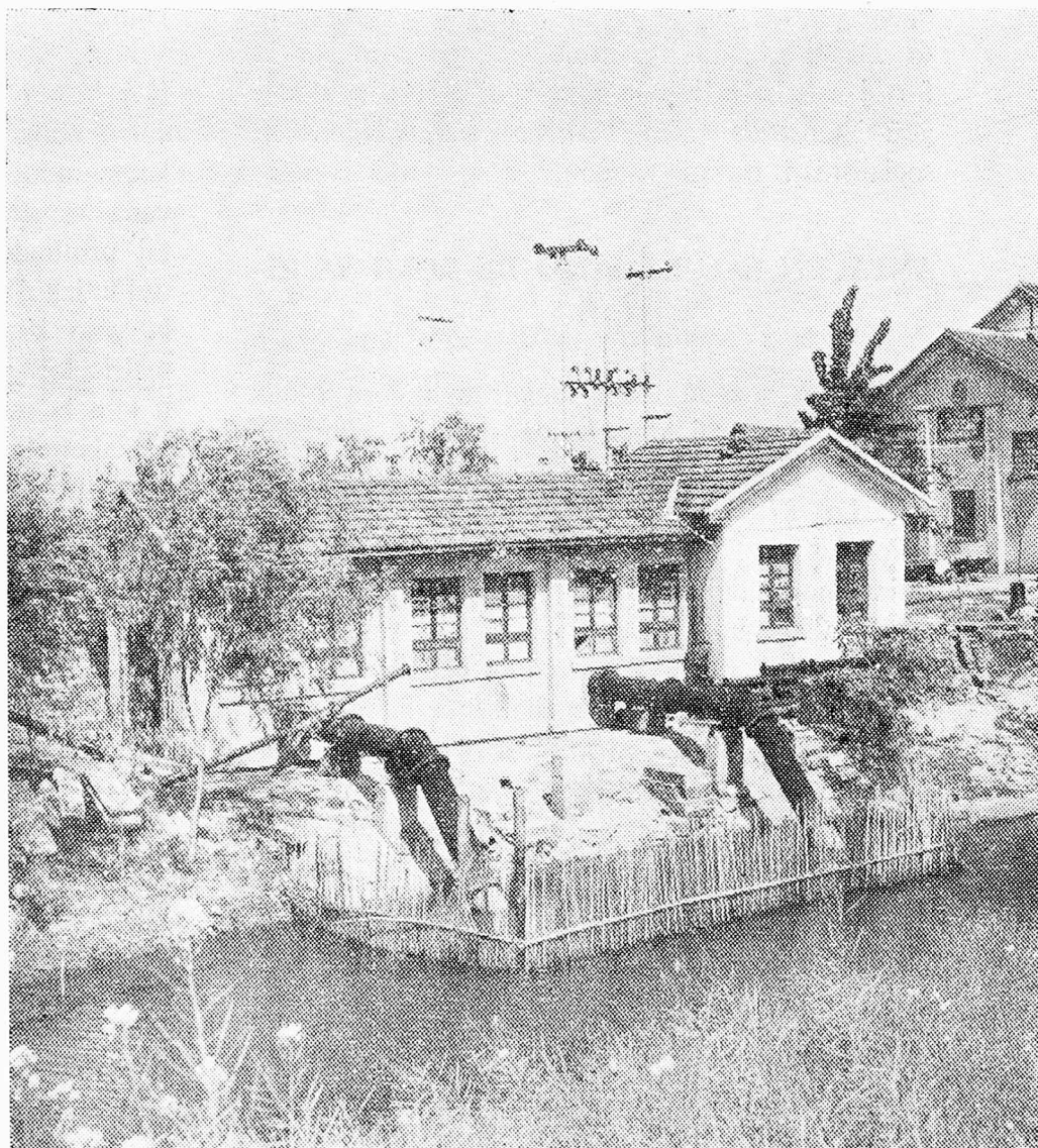
Unu el la malgrandaj elektraj pumpstacioj por irigaciado kaj drenado.
