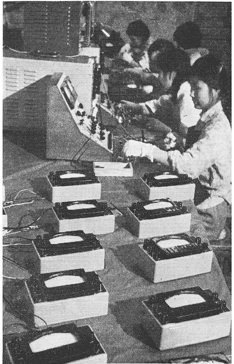
Teknika kontrolado antaŭ elfabrikigo de la dikecmezuriloj
