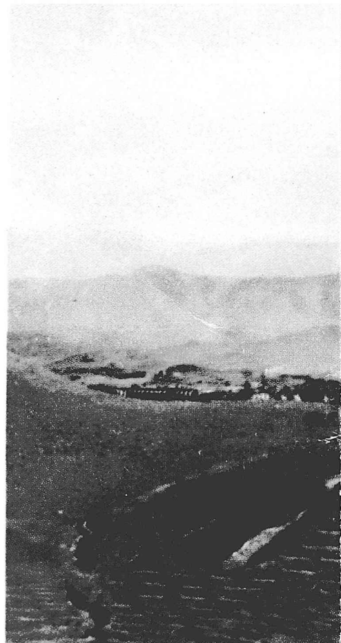
Novaj fabrikoj en izola valo
