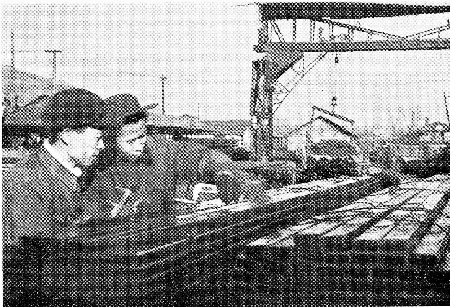
Kontrolado de ortangulaj senjuntaj ŝtaltuboj por baldaŭa elporto.
