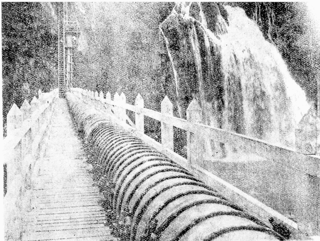
Lignan akvokondukan tubon oni konstruis en Giangkoŭ-gubernio de Gujĝoŭ-provinco por irigaciado.
