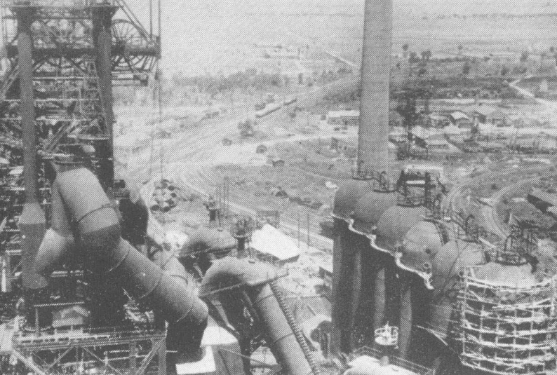
Konstruado de la dua aŭtomata blovforno, la Blovforno N-ro 7 de la Feraŝtala Kompanio de Anŝan.
