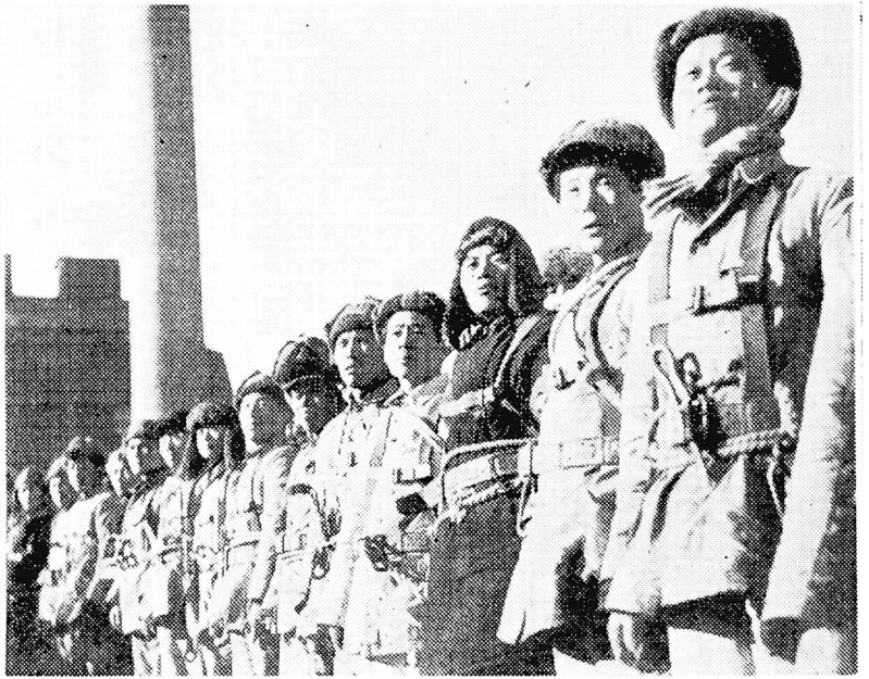
Konstruaj laboristoj laborantaj en alto estas ĉiuj provizitaj per sekurigaj rimenoj.
