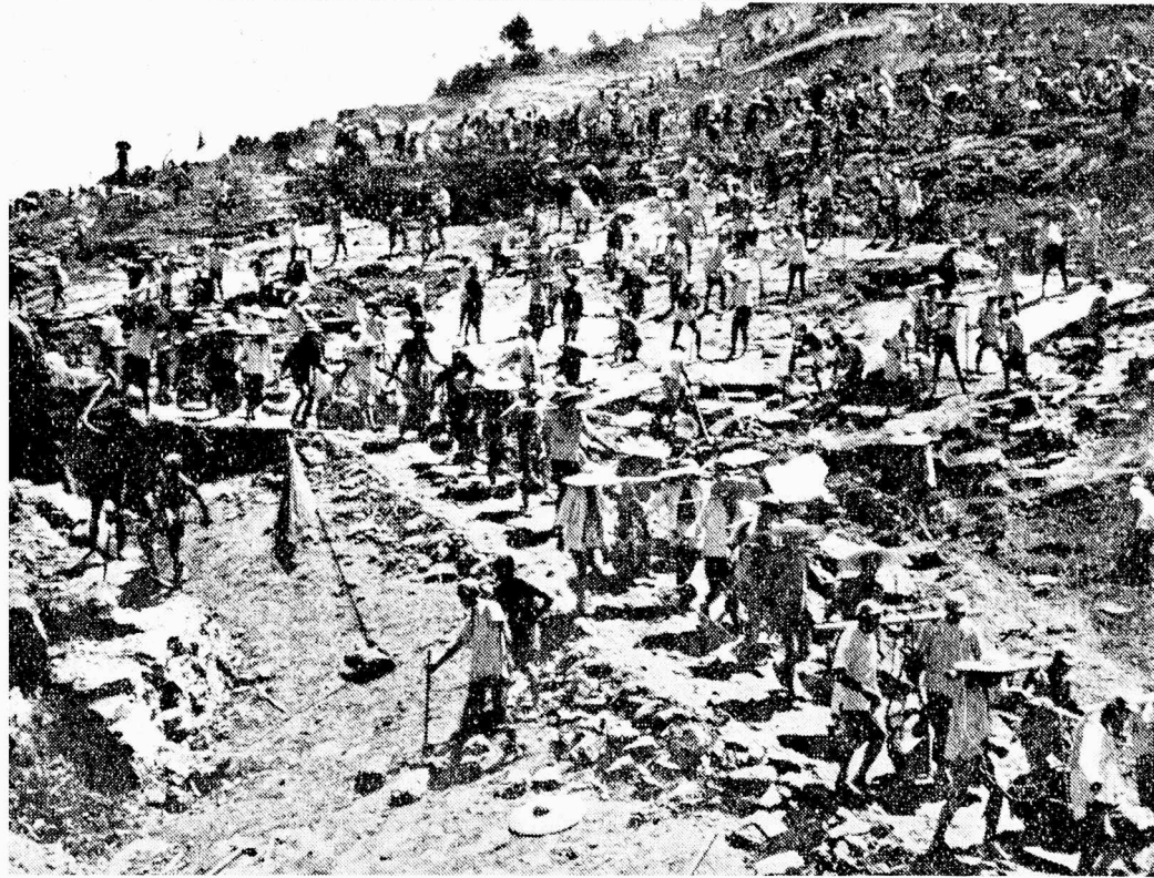
Miloj da kamparanoj penlaboras por konstrui la vojfundamenton.
