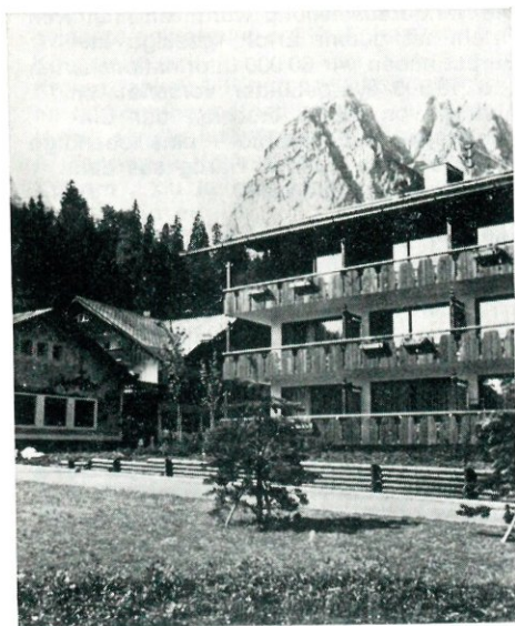
Foto: Haus Hammersbach kun montoj Waxensteine
